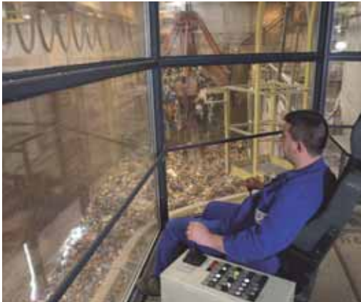
Im Müllheizkraftwerk wird aus Abfällen Fernwärme und Strom erzeugt.
